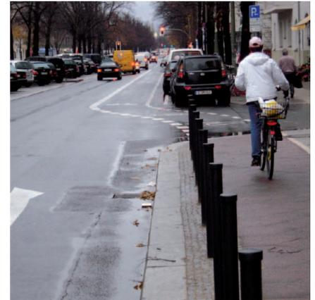
Blockierung der Radverkehrsanlage zu verhindern, wurde der Abschnitt bis zur Einmündung Stormstraße als Radweg baulich angelegt. In den Sicherheitsstreifen zur Fahrbahn wurden Poller eingebaut. Im Übergangsbereich zu den vorhandenen baulichen Radwegen jenseits der Marathonallee wurden in beiden Fahrrichtungen kurze Radfahrstreifen markiert.
